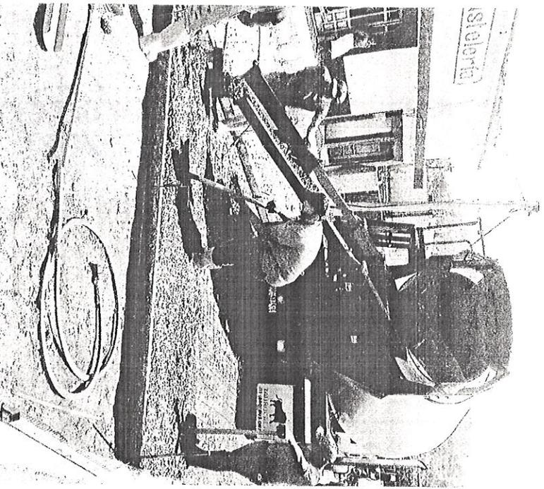
CONCRETO PREMEZCLADO RESISTENCIA NORMAL VACIADO CON CARRETILLA Y BOTES
